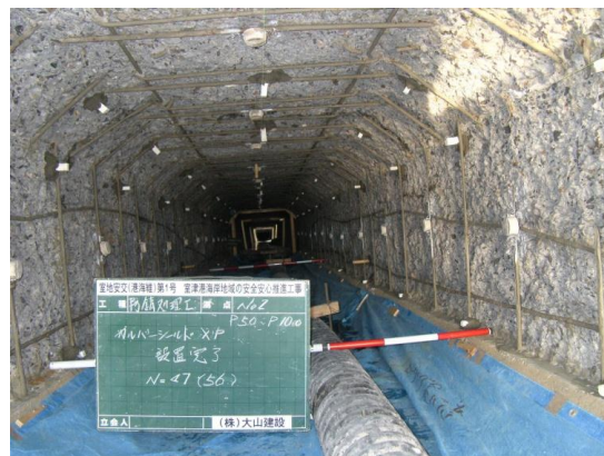
天井・壁面部分
